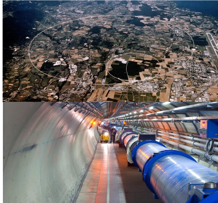
Figura 5. El Gran Colisionador de Hadrones, LHC, en la frontera franco-suiza. Izquierda, vista aérea del anillo de 27 km de circunferencia; derecha: interior del túnel que aloja los imanes superconductores del acelerador. Imágenes: CERN.
