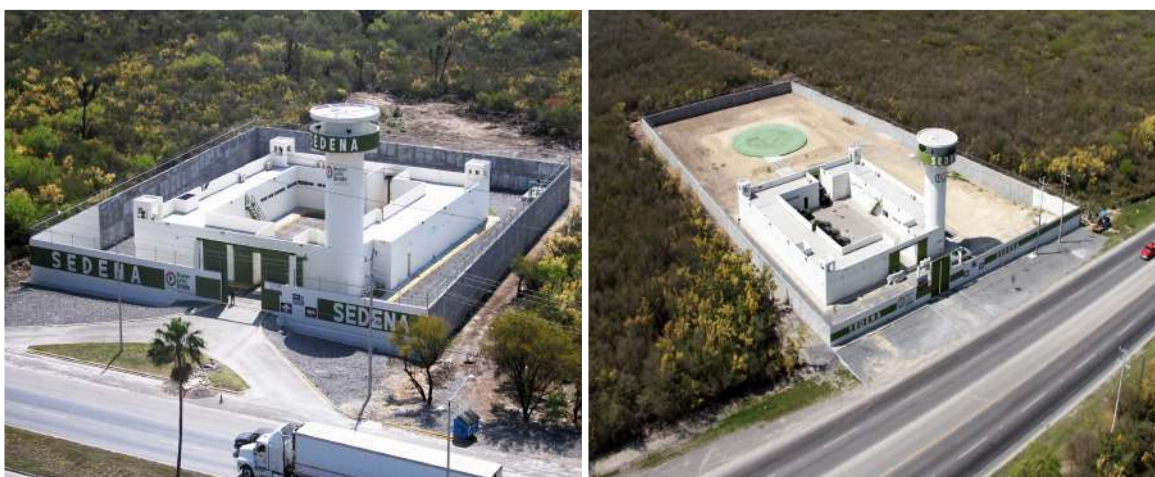
Gráfico 25: Puntos Fijos de Control, muestra de infraestructura terminada y en operación, puesta a disposición de la SEDENA en comodato 2011 -2015.
